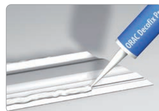
Enduisez la corniche de colle de pose
