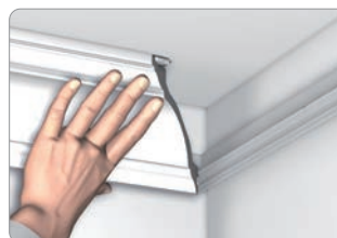
Bevestig de kroonlijst op de rail en tegen het plafond
