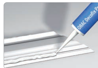
Breng de installatielijm aan op de kroonlijst
