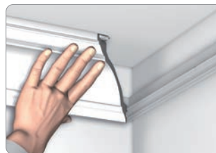
Fissa il profilo sul binario e contro il soffitto
